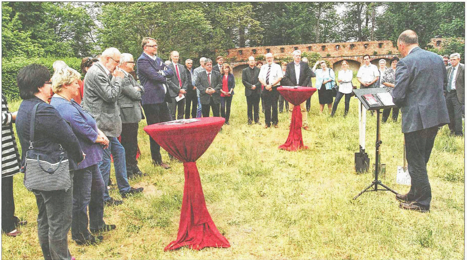
Torsten Ernst, Theologischer Geschäftsführer des Diakonissenkrankenhauses Dessau, konnte zahlreiche Gäste zum symbolischen Spatenstich begrüßen.
