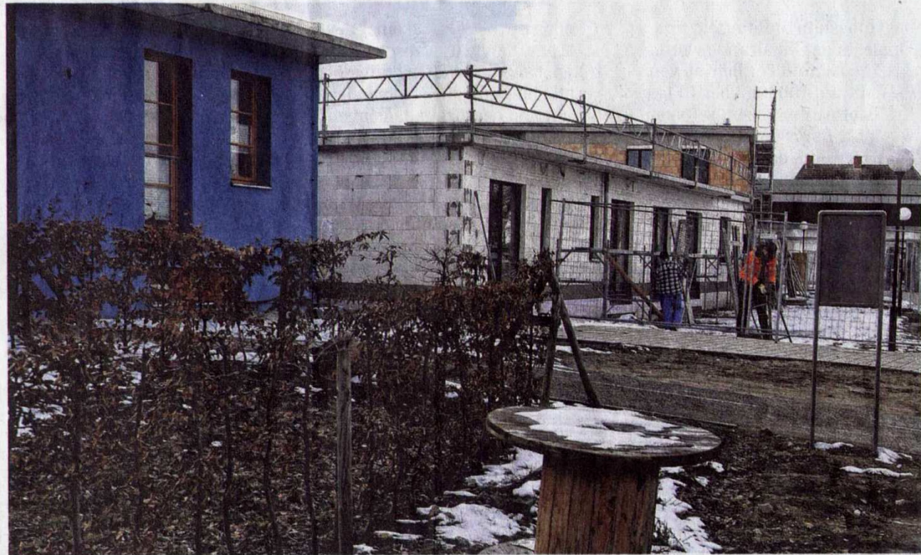
Der Neubau neben dem Hospiz wächst in die Höhe, auch die Außenanlagen werden neu gestaltet.
